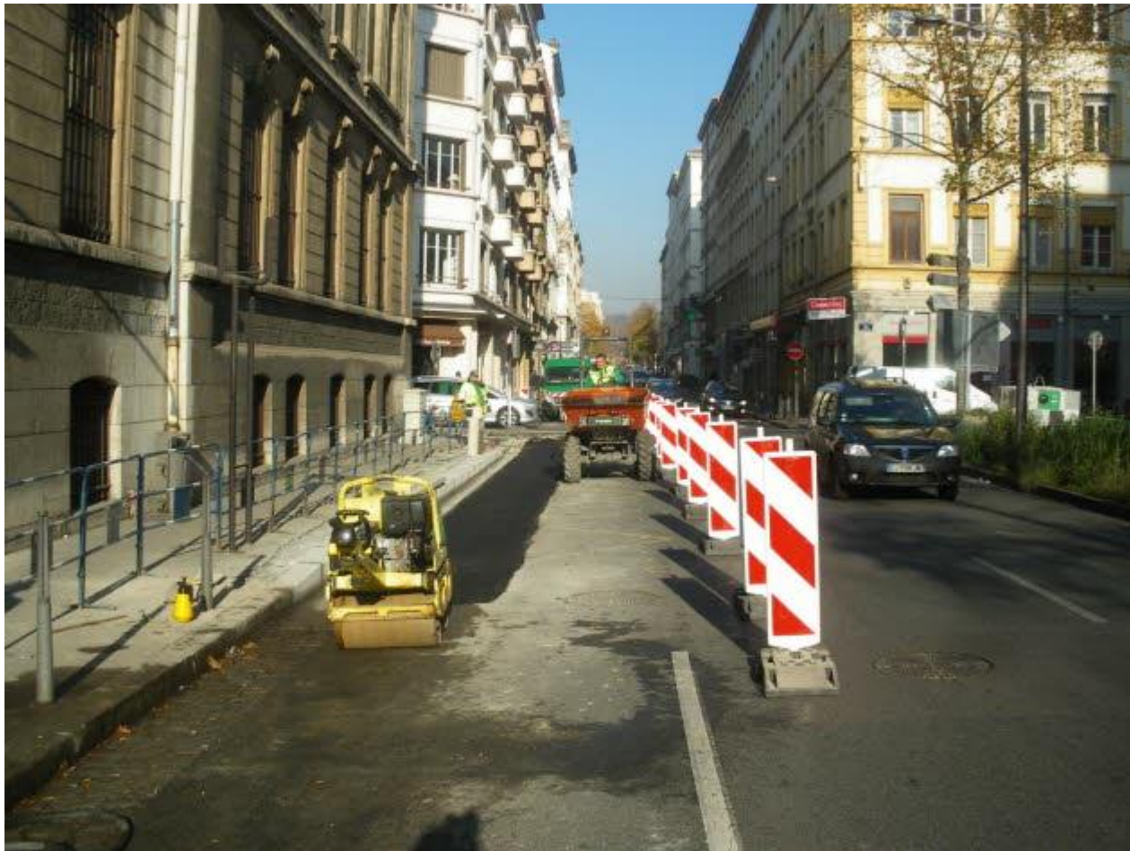
Le chantier a commencé par la surélévation du trottoir devant l'arrêt « Mairie du 6 e » de la ligne 38. Photo Alain Rousset
